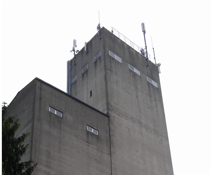
Abbildung 4.3.: Aufnahme der Basisstation auf einem Turm
